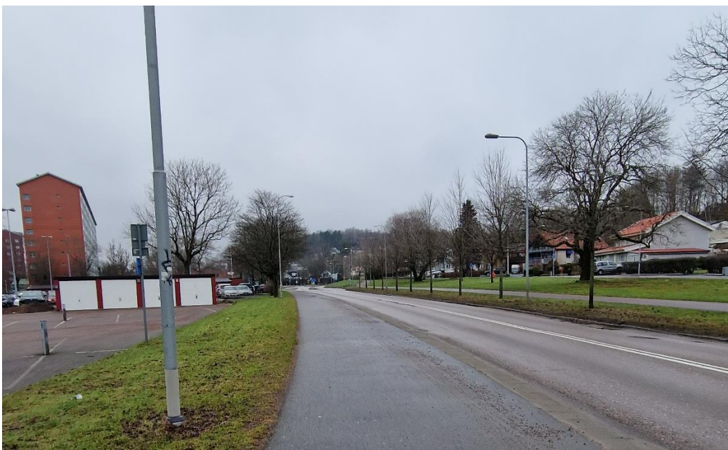
Figur 8. Litteraturgatan norr om korsningen med Kåserigatan, vy mot norr.
