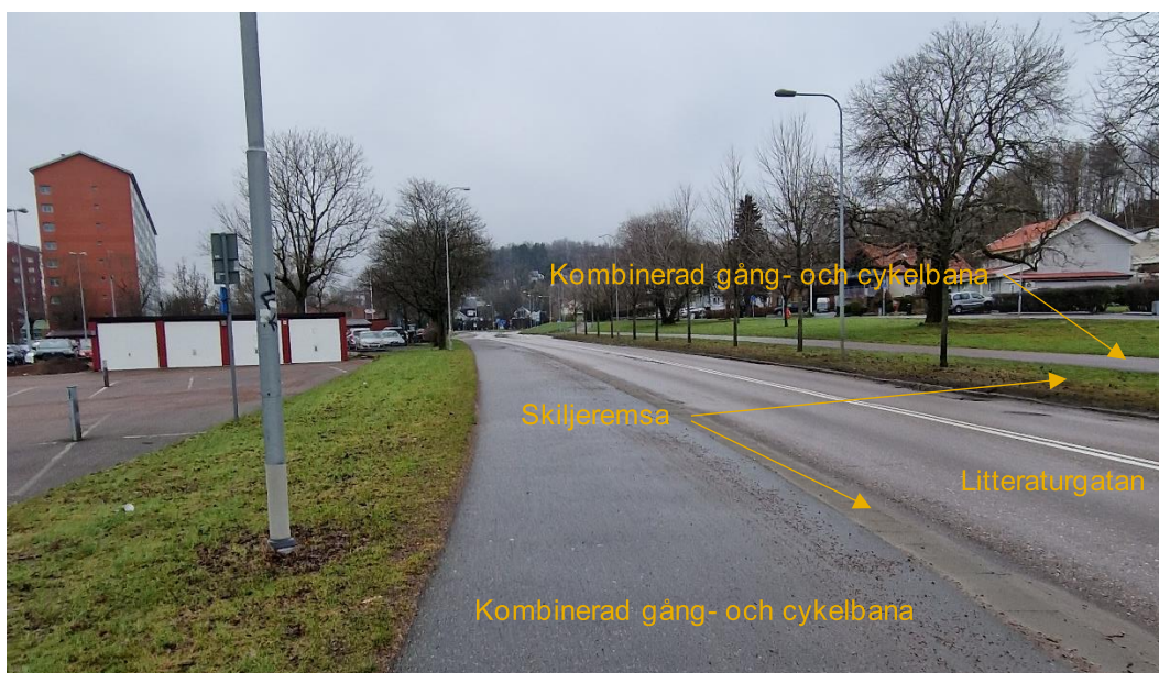
Figur 3. Litteraturgatan strax om korsningen med Kåserigatan, vy mot norr. Foto: Sigma Civil.
